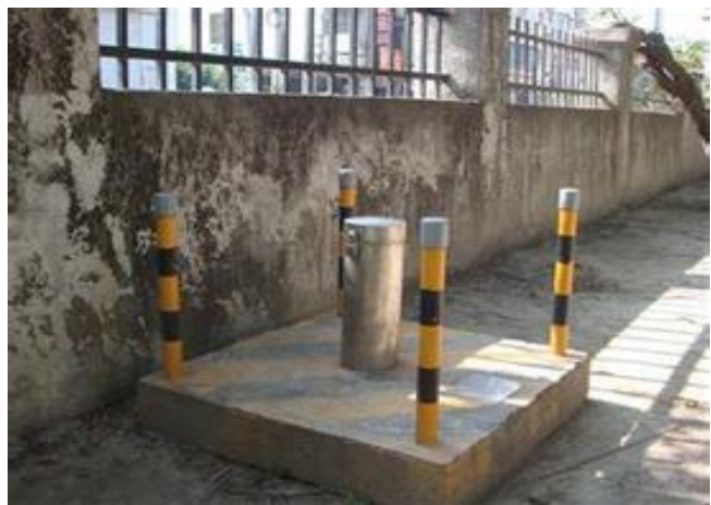
图6.4-3 井口保护装置侧视图图6.4-4井口保护装置实物图
